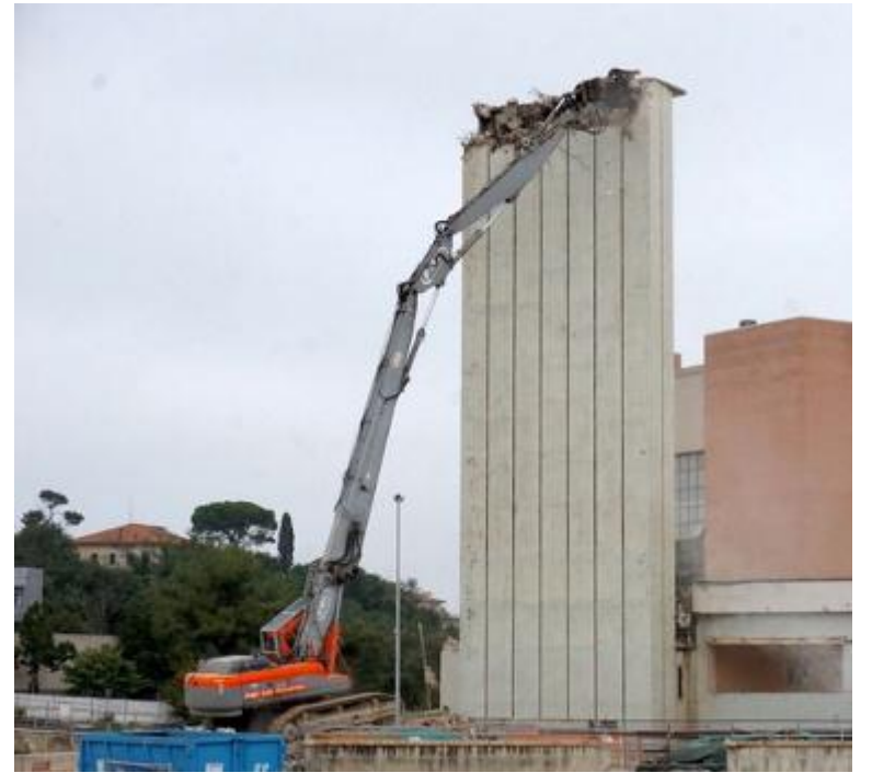
L'intervento della gru per abbattere la storica torre dell'ospedale di Torrette
